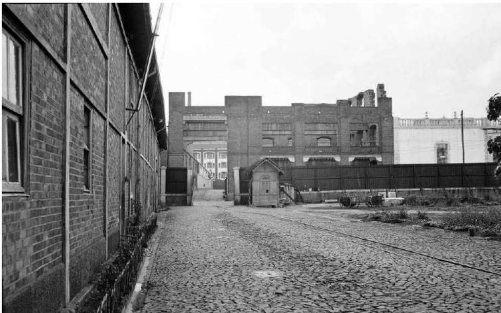
Fig. 20 – Vista da Fábrica Seixas e do Palácio da Mitra antes de 1941, onde se vê a existência de um aterro do outro lado da Rua do Açúcar com uma via de carris que servia para levar a matéria prima do rio até às zonas de transformação. CML, Arquivo Fotográfico, MCH00008
